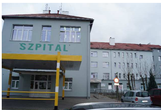
Budynek Szpitala w Ostródzie
